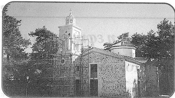
Η εκκλησία της Αγίας Παρασκευής Καρυνών άλλαξε εξωτερικά αφού αφαιρέθηκε το ασβεστόμα και αποκαλύφθηκε η παλαιά λιθοδομή.
